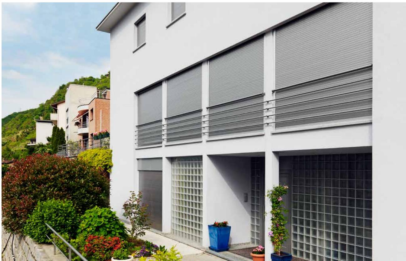
Der Rollladen RL 37 von Schenker Storen ist ein platzsparender Rollladen, der eine gute Abdunkelung der Wohn- und Schlafräume sowie einen Einschleichschutz bietet. Die leicht gerundeten Schiebepprofile sind geschäumt, was eine höhere Festigkeit sowie eine bessere Schall- und Wärmedämmung bewirkt. Die Führungsschienen sorgen zudem für eine geräuscharme Bedienung.
