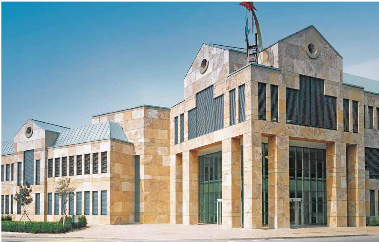
Die GM 100 ist die einzige zwangsangetriebene Ganzmetallstore auf dem Markt. Ihre einzigartige Technik sorgt dafür, dass sie in jeder Position und jeder Lamellenneigung automatisch verriegelt, womit sie Ihnen grösstmögliche Sicherheit bietet.
