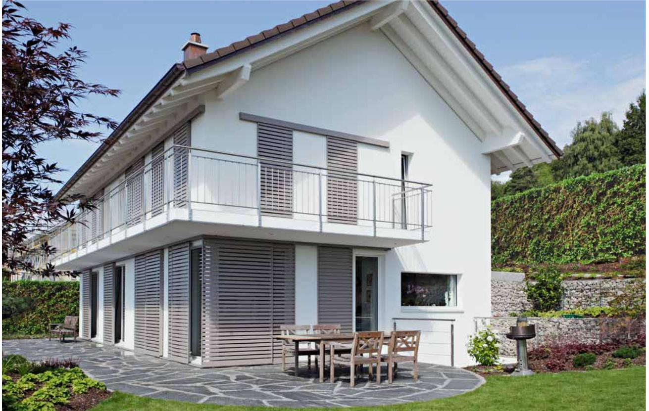
Schiebeläden sind aus der aktuellen Neubauarchitektur nicht mehr wegzudenken. Aus der Familie der Klapppläden entstanden, hat sich dieses System sowohl bei Architekten wie auch bei privaten Bauherren zu einem beliebten Element entwickelt. Innenräume lassen sich mit Schiebeläden sowohl vor zu starkem Lichteinfall als auch vor neugierigen Blicken schützen.
