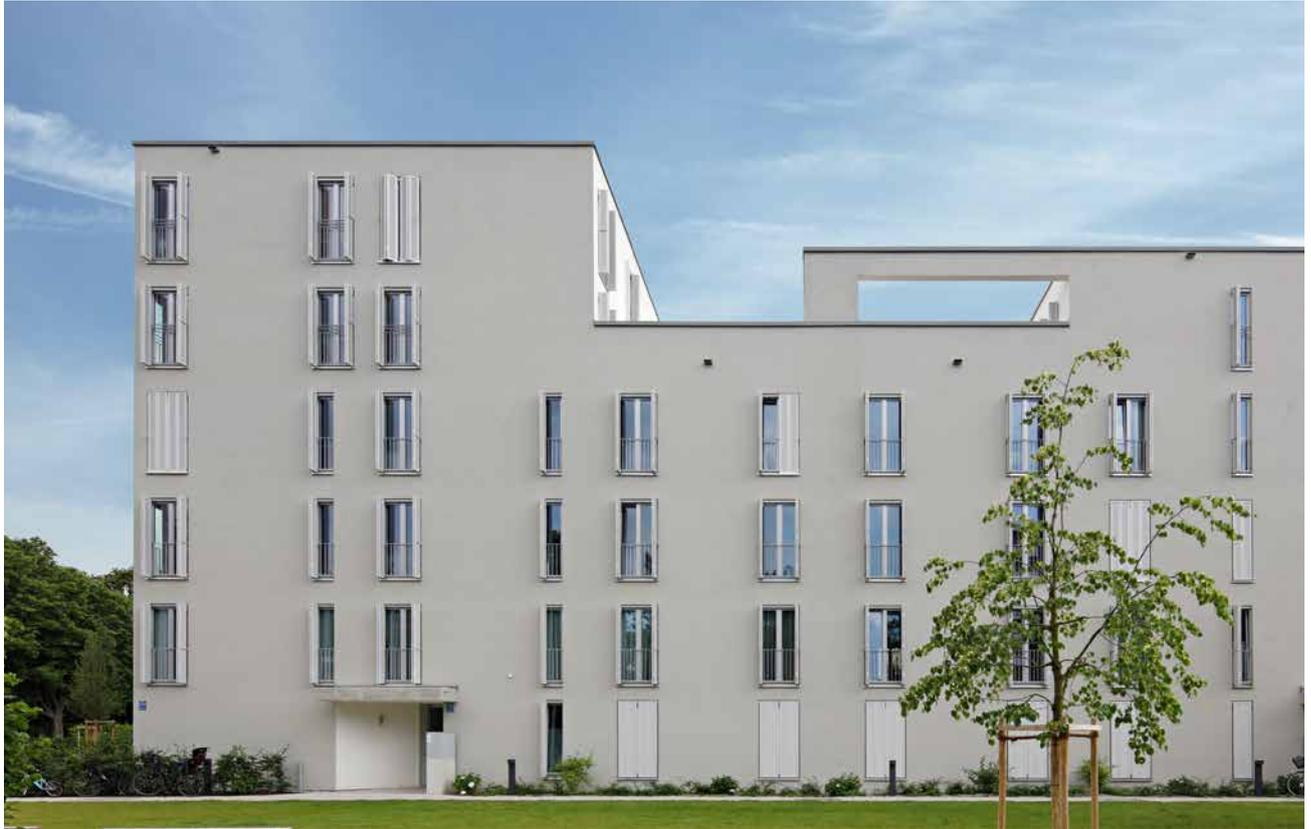
Faltschiebeladen sind ein ästhetischer und gleichzeitig platzsparender Sonnenschutz, der eine Fassade bewusst akzentuiert. Da die Ladengrößen flexibel gewählt werden können, fügen sich Faltschiebeladen in geöffnetem Zustand elegant in die Leibungen und das Fassadenbild ein. Für die Ladenfüllungen stehen Ihnen, je nach Bedarf, verschiedenste Möglichkeiten offen, und selbstverständlich können Faltschiebeladen auch mit Elektroantrieb ausgestattet werden.
